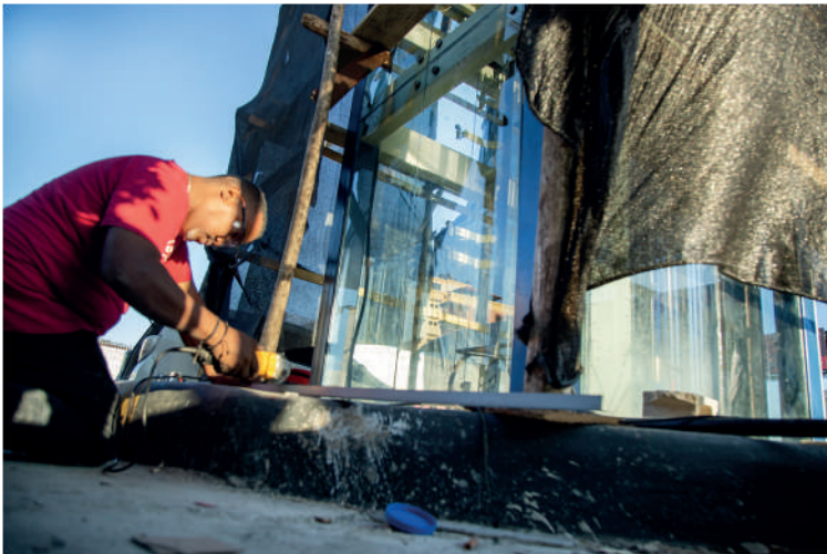
Trabajos de remozamiento de ascensores línea 1
